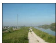
Argine Dx Adige
