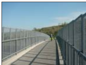
Ponte ciclopedonale su autostrada A1
