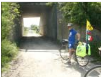
Sottopasso statale Romea presso ponte sul Po di Goro argine sx
