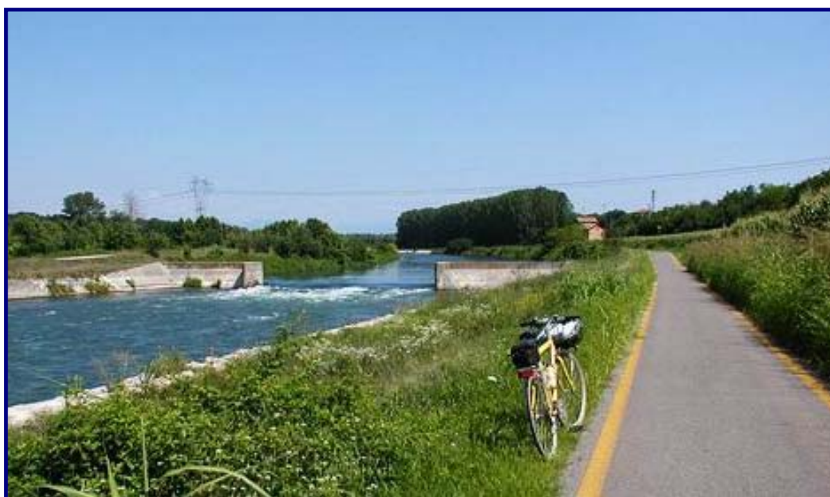
FOTO 11 - Pista ciclabile su sponda fluviale in asfalto ecologico
