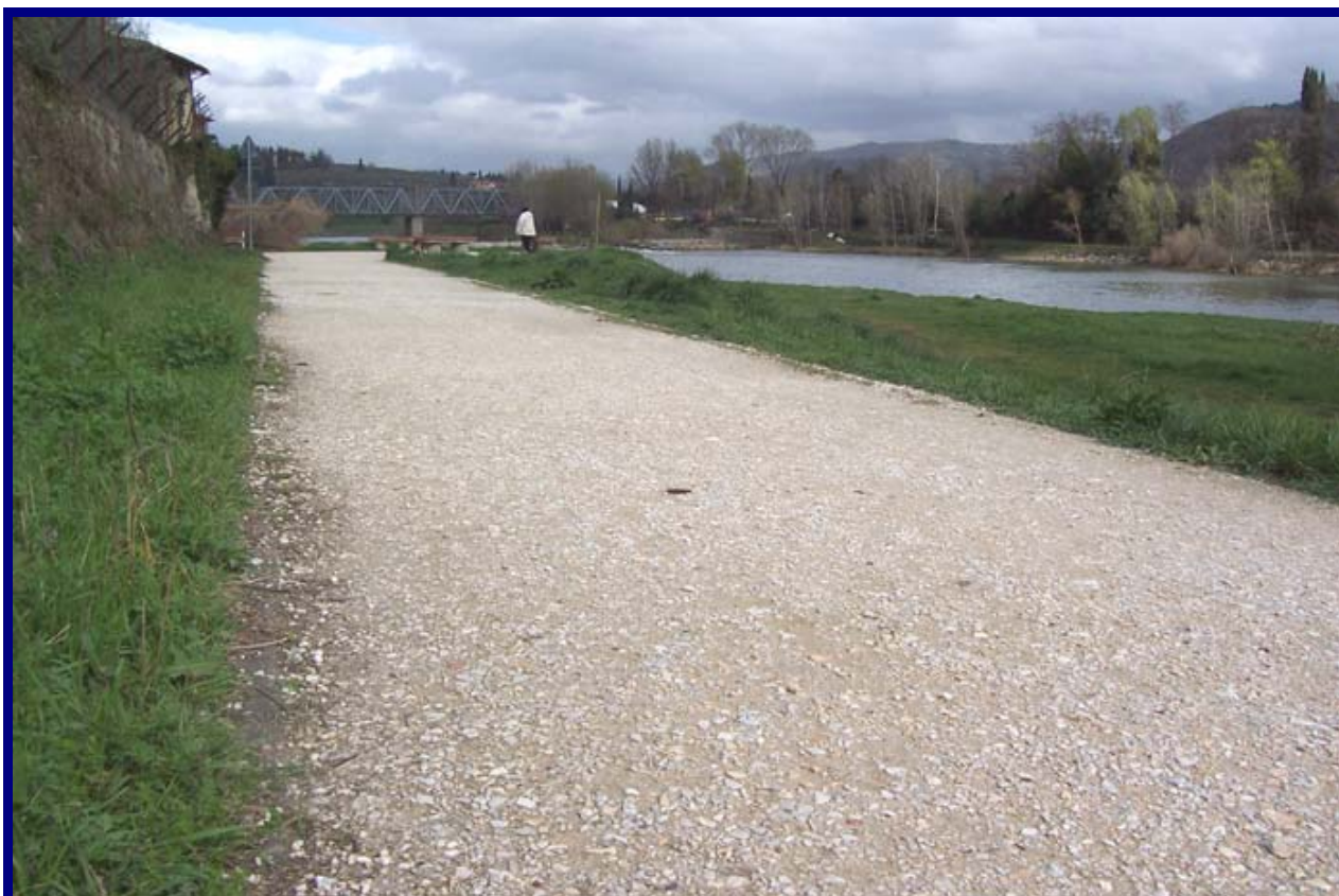
FOTO 13 - Pista ciclabile in stabilizzato di cava
