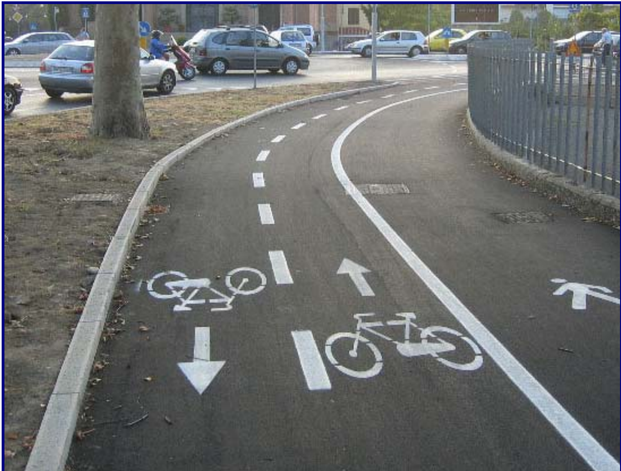
FOTO 9 – Segnaletica orizzontale costituita da linee di demarcazione e da eventuali simboli ripetuti sulla pavimentazione
