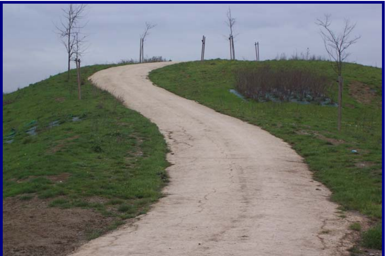
FOTO 14 – Trattamento di una strada vicinale esistente con stabilizzato tipo “Diogen” o similari
