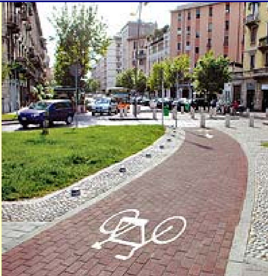
FOTO 12 - Pista ciclabile in blocchetti di cls
