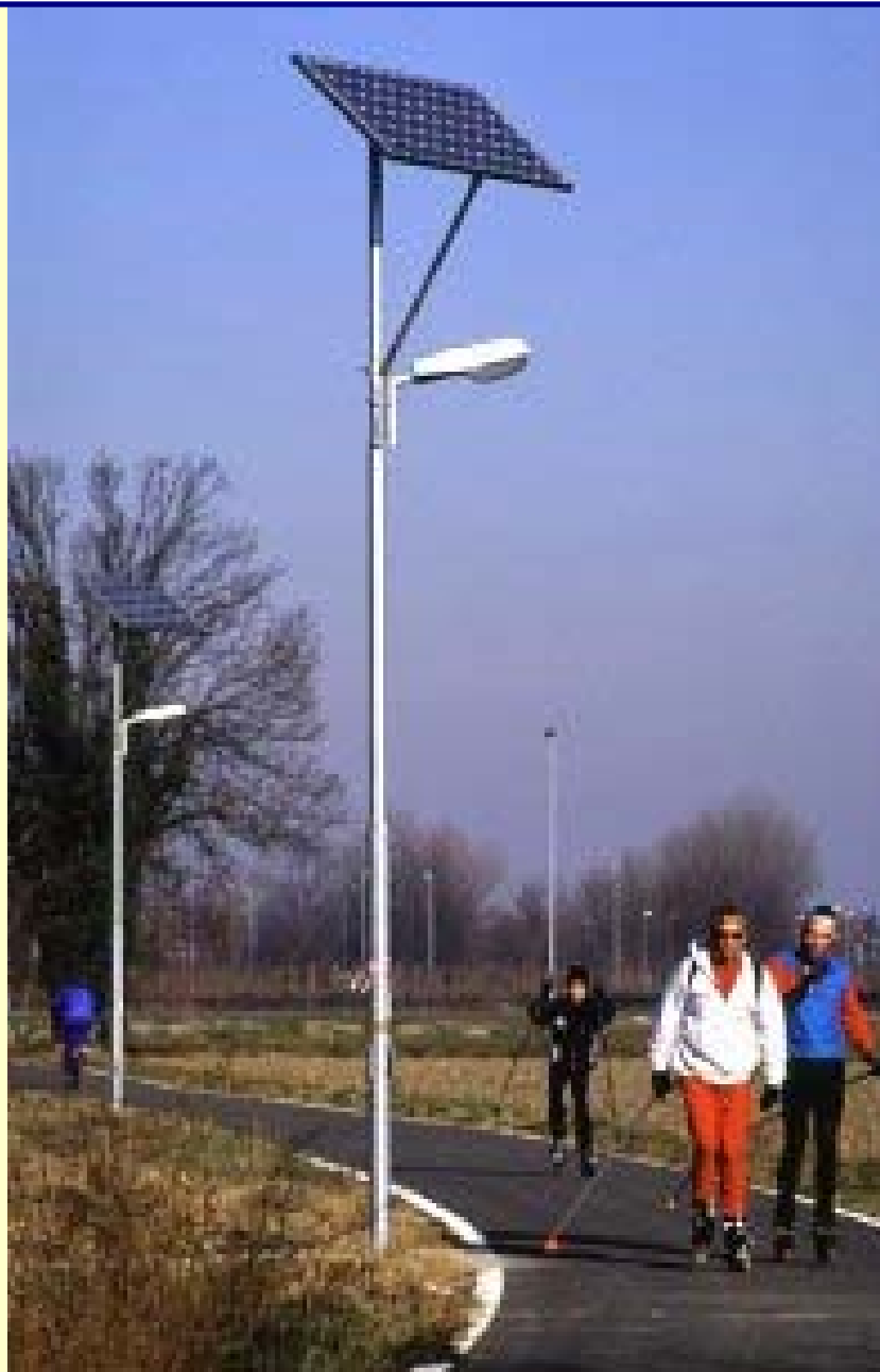
FOTO 8 – Lampioni a pannelli solari su piste ciclo-pedonali
